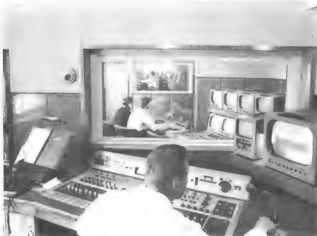
Bild 2. Regieräume eines Fernseh-Mehrzweckstudios. Vorn das Tonmischpult, hinter dem Durchblick der Bildregieraum und ganz hinten, im dritten Raum, die Lichtregie
